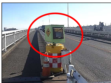
国道1号馬入橋(神奈川県平塚市)
